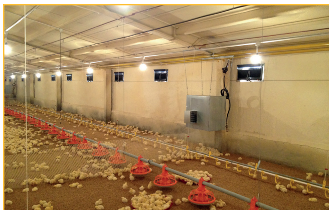
INSTALACJA WEWNĄTRZ BUDYNKU
